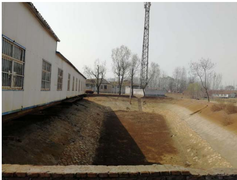
污水处理站及污水处理池
